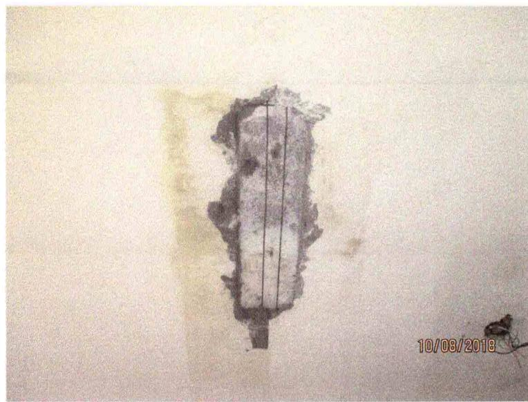
**Detalhe dos danos causados nos forros devido as infiltrações por falta de impermeabilização da cobertura.**
