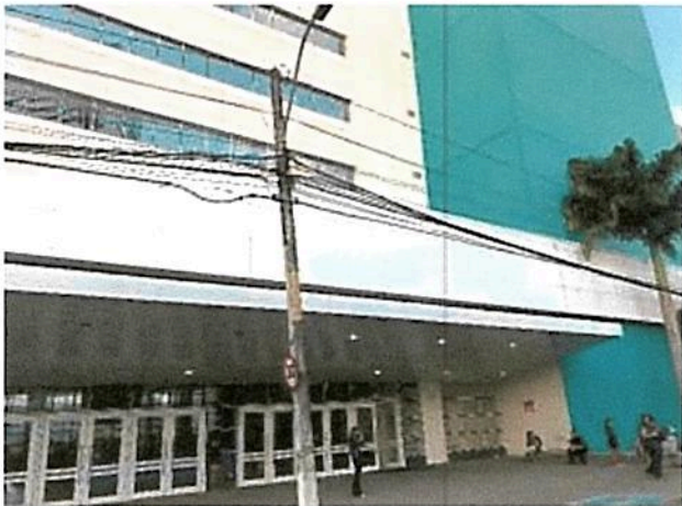
Externa - acesso pedestre
