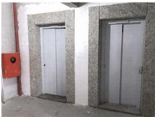
Hall dos elevadores
