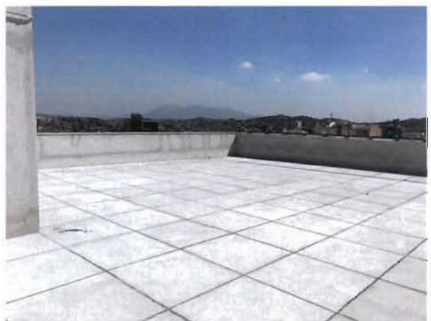
Cobertura – Laje Impermeabilizada
