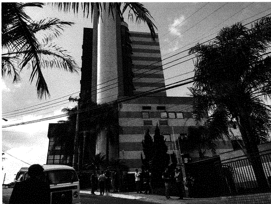
Fachada de fundos
