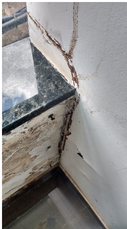
Fachada -infiltrações
