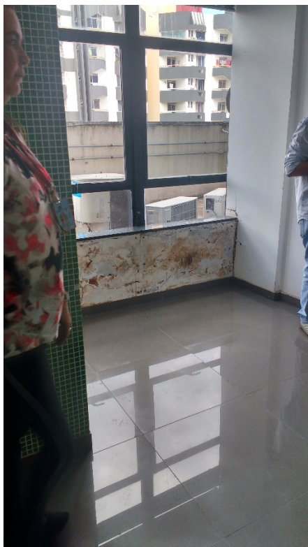
Fachada -infiltrações
