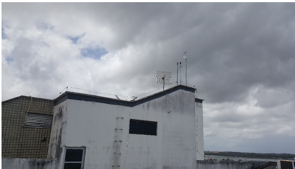
Instalação de mastro e captor de para-raios com elementos de interferência
