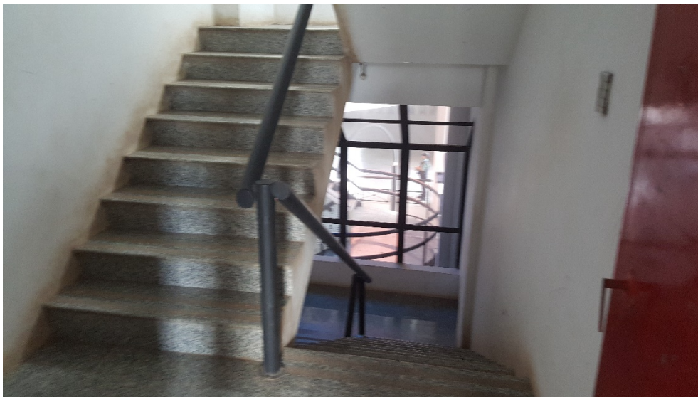
Escada de enclausurada existente
