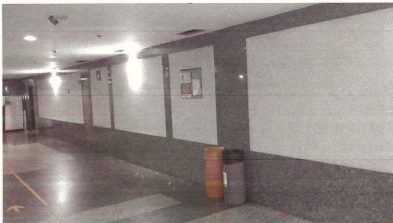
Vista do hall de elevadores no térreo, observando-se o acabamento em materiais nobres, piso e paredes revestidos em granito. Abaixo parede frontal aos elevadores, com pastilhas e granito.
