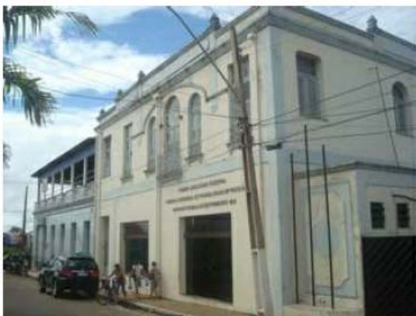
Foto 14 - Vista da Fachada antes da reforma
