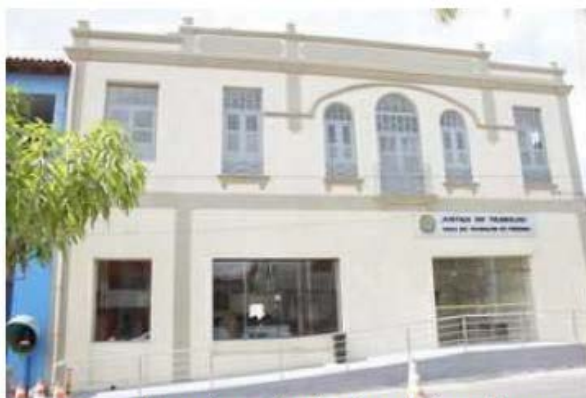
Foto 15 - Vista da Fachada depois da reforma
