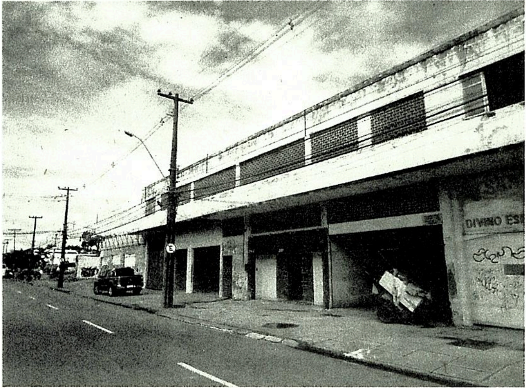
Foto 07 - Vista da fachada frontal - Imóveis da Av. Cruz Cabugá
