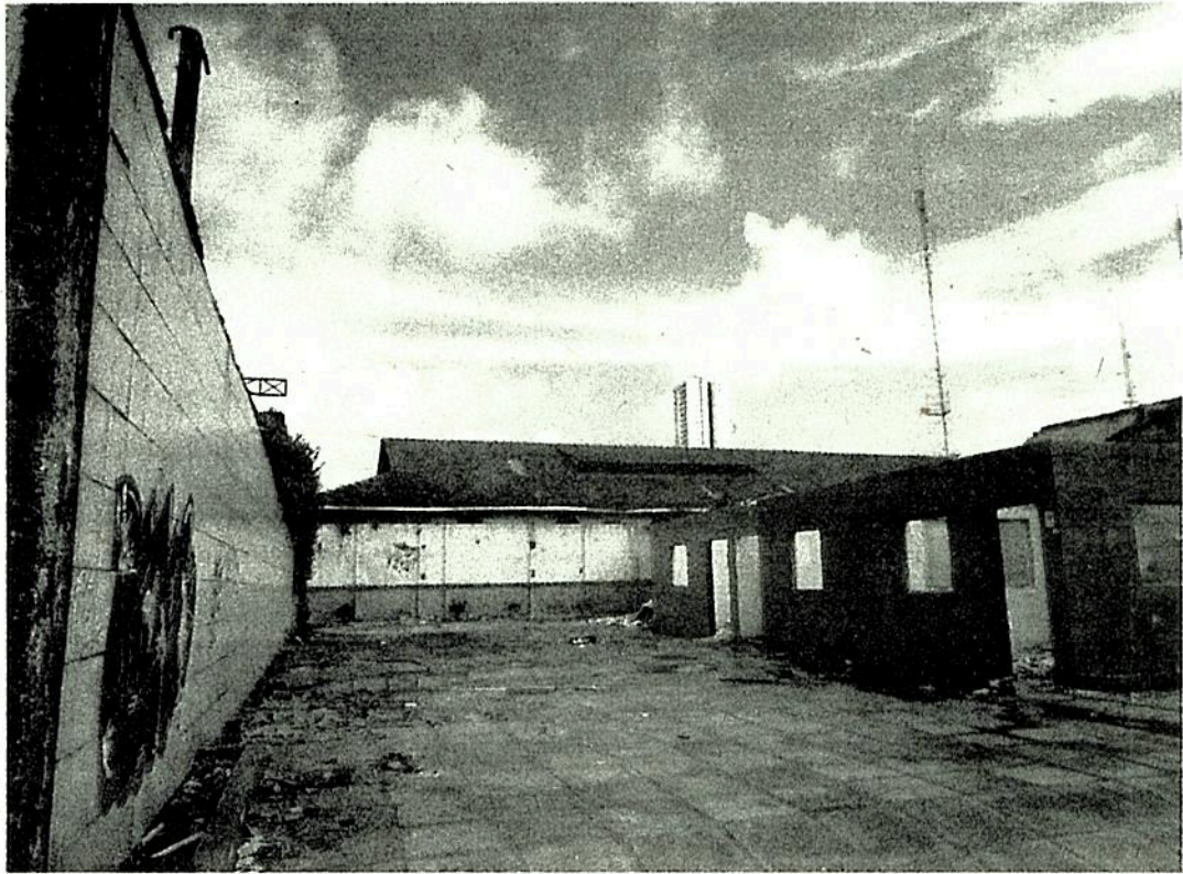
Foto 09 - Vista de imóvel demolido
