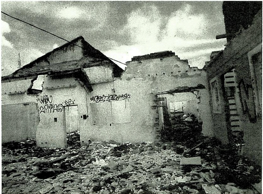
Foto 08 - Vista de imóvel demolido
