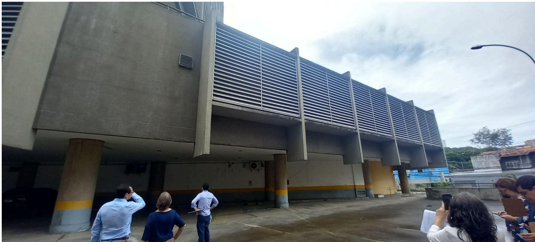
FACHADA - ESTACIONAMENTO PAV. TÉRREO
