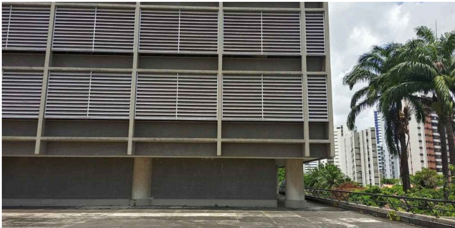
FACHADA - 2º PAVIMENTO
